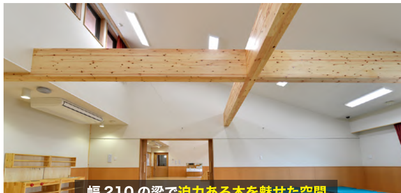
幅210の梁で迫力ある木を魅せた空間
