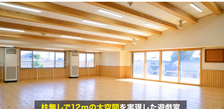
柱無しで12mの大空間を実現した遊戯室
